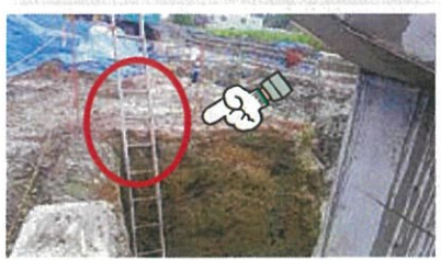
昇降用のハシゴが固定されていない。 【安全衛生規則第527条】
