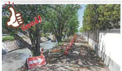
歩行者の通路が確保されていて、作業区域の明示がなされていた。
